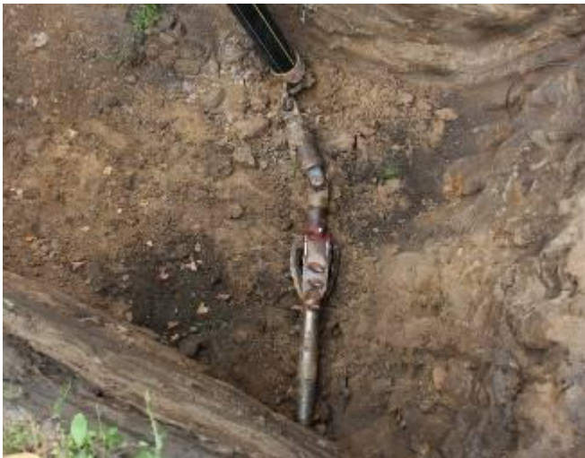
Буровая головка монтируется трубой и с расширителем собственного производства компании "БурМонтаж".
