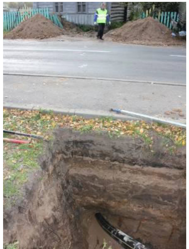
Протяжка первой трубы завершена.
