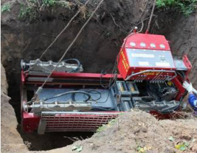
TERRA-JET 3008 E установлена в стартовом котловане.
