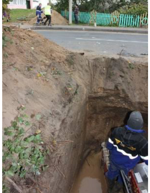
Вид на дорогу, под которой проходит буровая трасса.
