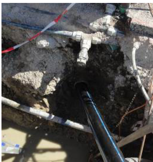
← Новая ПЭ - труба DA 125 мм затянута.
