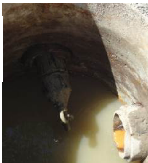
← Новая ПЭ - труба DA 125 мм затянута.
