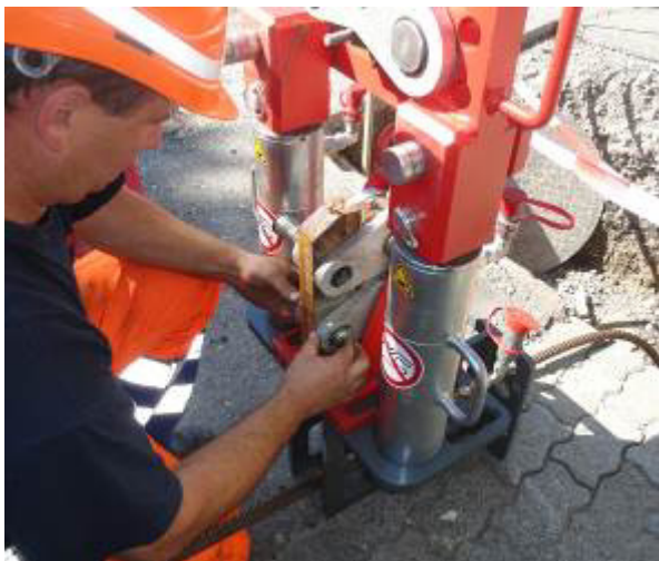
Заправка в головку установки стального троса.
