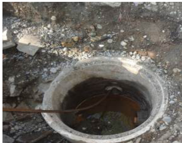
Стальной трос 22 мм заправлен в старую трубу.
