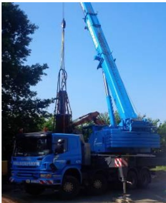
TERRA-Молот TR 565 закреплён на стальной трубе и готов к работе.
