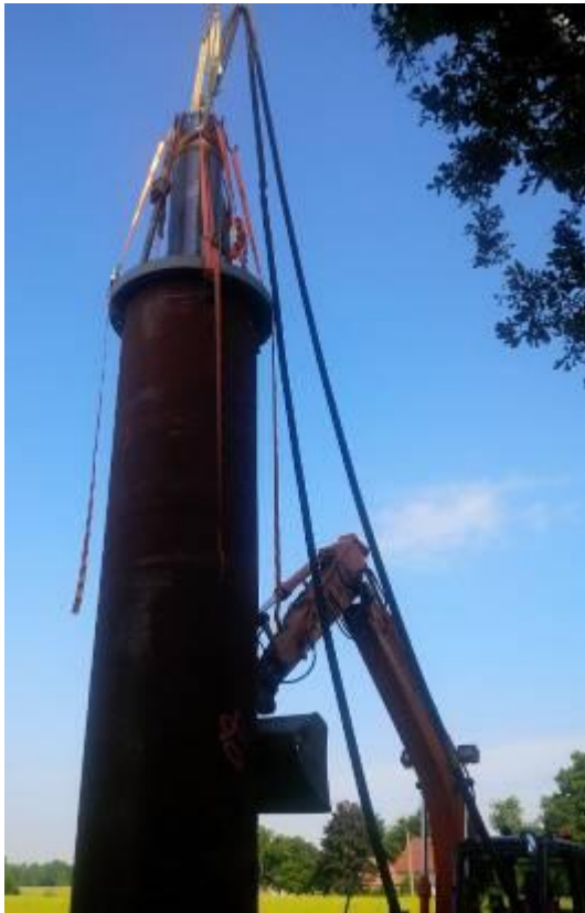
TERRA-Молот TR 565 закреплён на стальной трубе и готов к работе.
