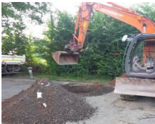
На 2-3 м в глубину для стальной трубы выкапывается траншея.
