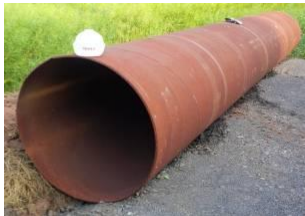
Стальная труба Ø 1'200 мм подготовлена для поднятия в вертикальное положение с помощью крана. Переходные кольца устанавливаются и закрепляются.
